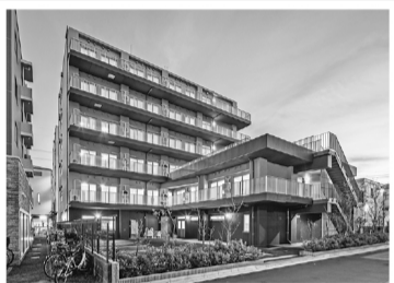
「タムスさくら」の杜の外観
